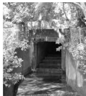
水源2 排水側溝
